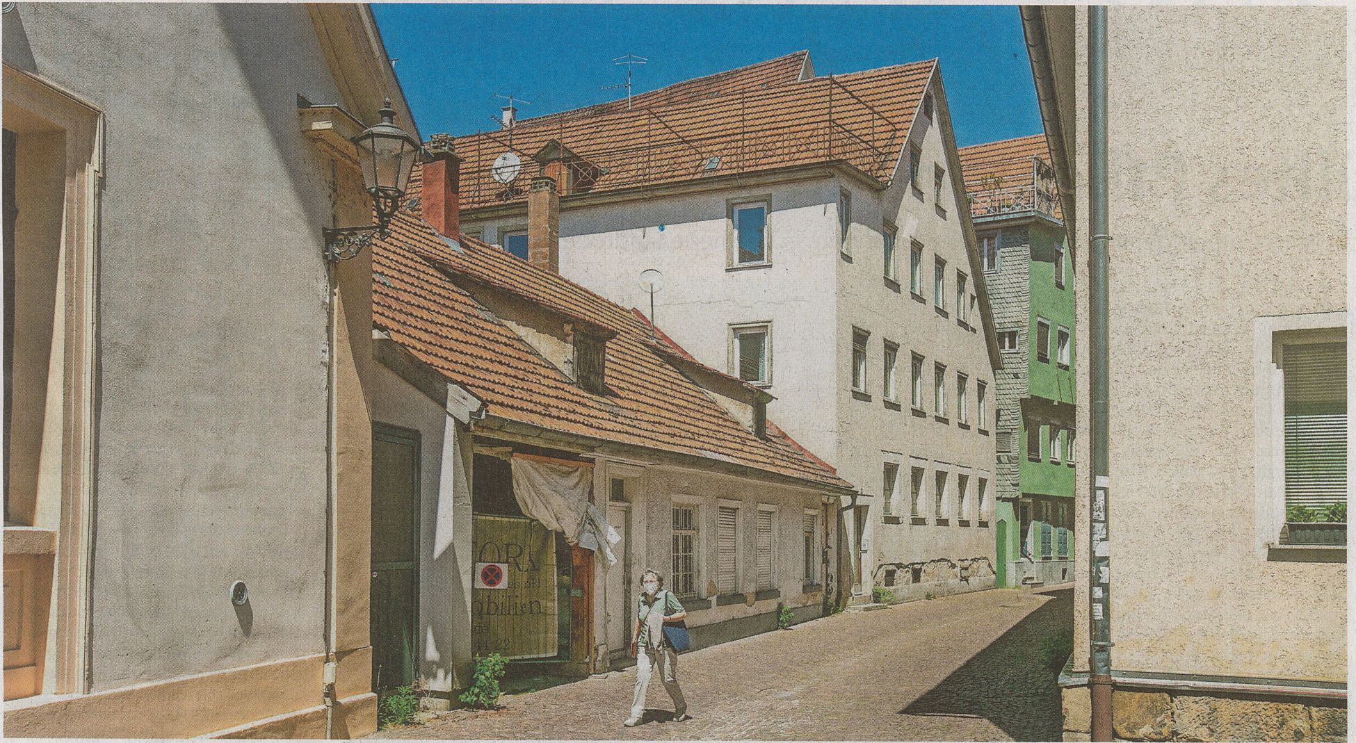
Wo heute in der Adlerstraße der Putz bröckelt, soll Wohnraum entstehen: Das Haus Nummer 2 wird saniert, die Nummer 2/1 durch einen Neubau ersetzt.. Foto: Roberto Bulgrin
